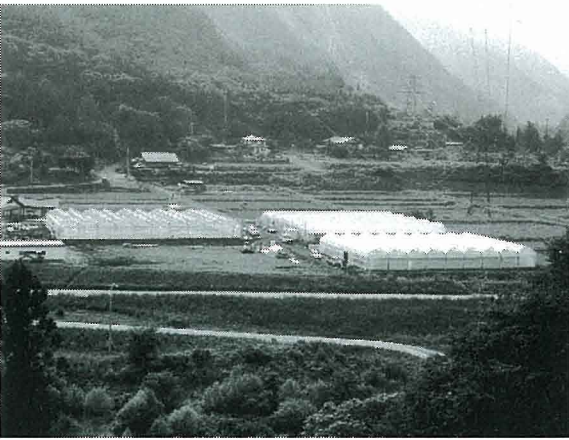
建設中の低コストハウス
