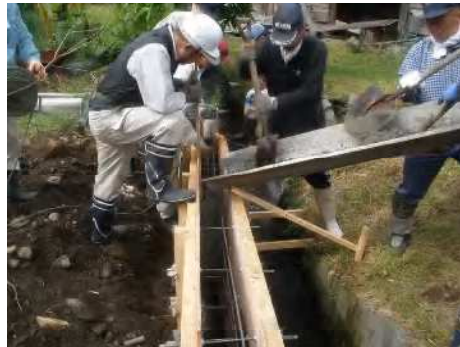
用水整備（永井野地区）
